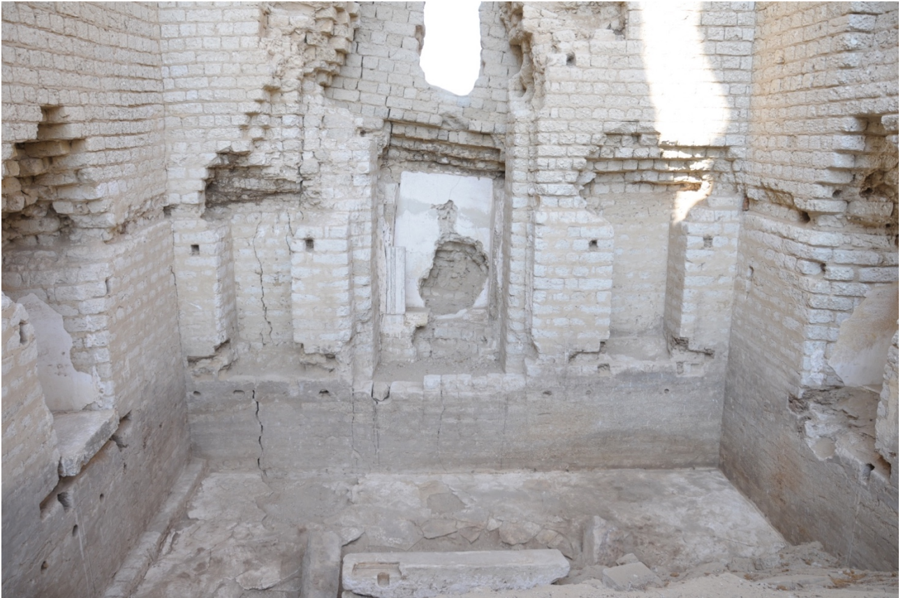
Fig. 4. Vista di ST6 A da sud.
